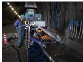
山形県国道トンネル はつり工事 置賜建設(株)
