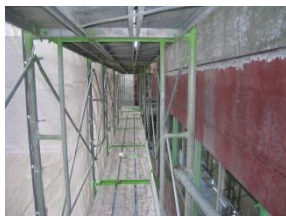
岩手県北上市南小学校 外壁塗膜除去工事 (株)栄組
