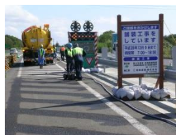
北海道日高自動車道 ライン除去工事 (株)ゲーテック
