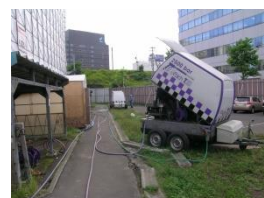
北海道札幌市市営団地解体 アスベスト対策塗膜除去工事 (株)ゲーテック
