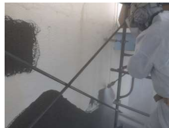
道営住宅団地解体工事 外壁塗膜除去 (株)ゲーテック
