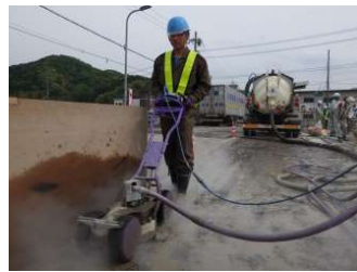
舞鶴市松嶋橋橋梁維持補修工事 (株)ゲーテック、置賜建設(株)
