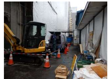
第一札幌ビル解体工事 外壁塗膜除去 (株)ゲーテック、(株)栄組
