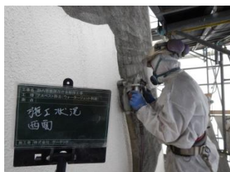
簡易裁判解体工事(北海道) 塗膜(アスベスト)除去 2018年1月 (株)ゲーテック
