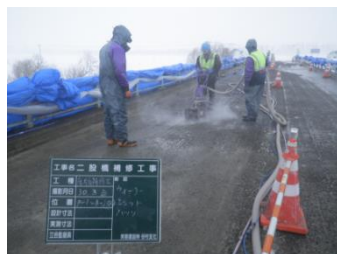
橋梁床板補修工事(北海道) 床板上部表面処理工 2018年3月 (株)ゲーテック
